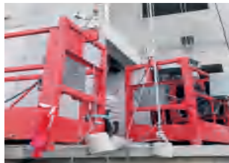
吊篮防风措施
