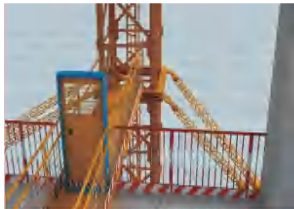
大型设备防台风应对措施
