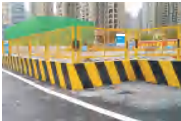
基坑挡土墙及临边防护
