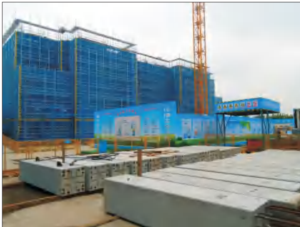
装配式建筑施工现场
