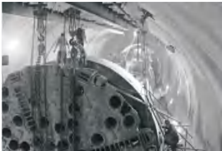
TBM拆卸
