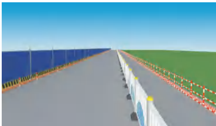
施工便道安全防护
