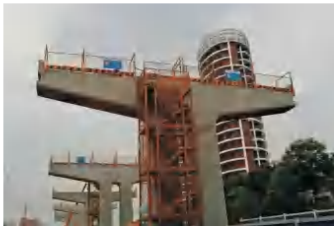
垫石施工防护
