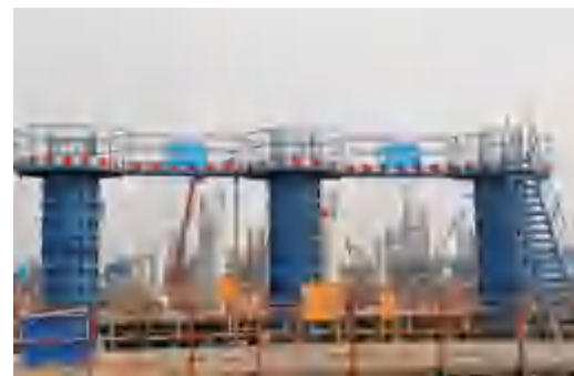
定型化模板操作平台
