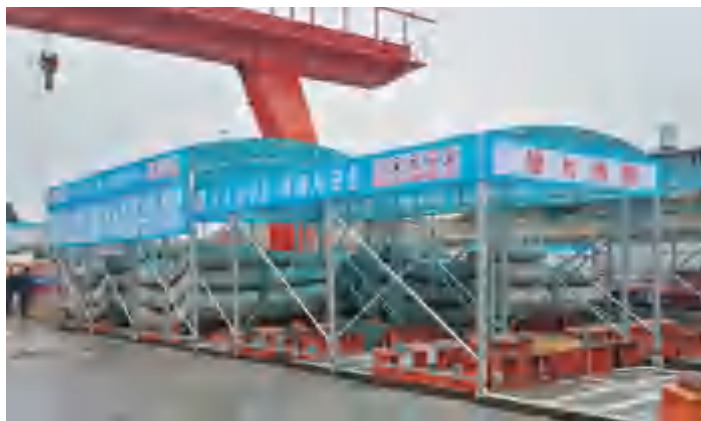
管片防雨棚及基座
