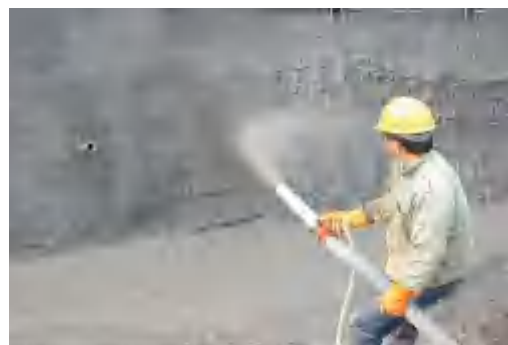
喷锚及钢筋网片护坡
