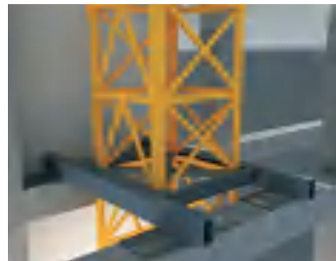
内爬附着装置安装
