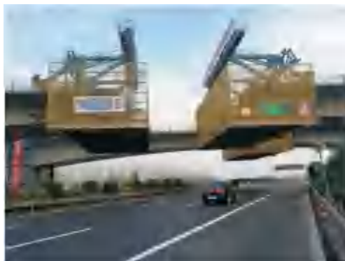
挂篮作业平台封闭
