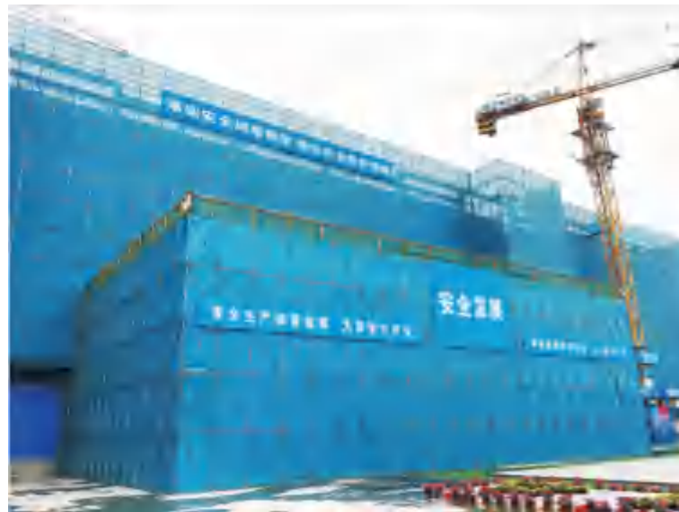
镀锌钢板网或冲孔钢板网代替安全网的外脚手架
