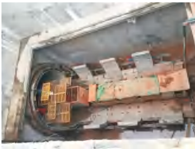
洞门负环拆除图
