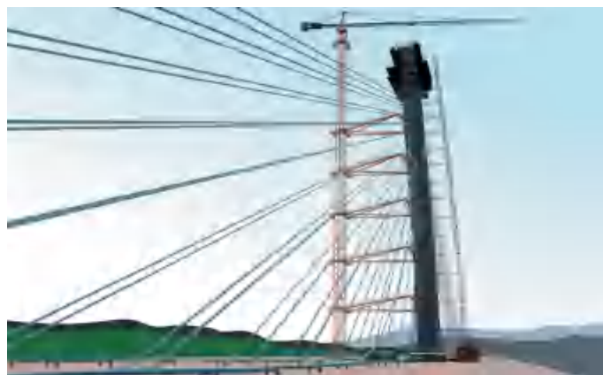
斜拉桥拉索施工
