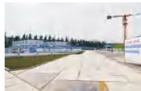
重载装配式混凝土道路
