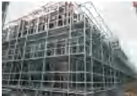
承插型盘扣式钢管支架
