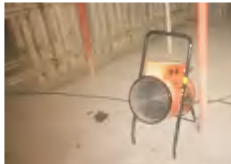
冬施电暖风升温措施
