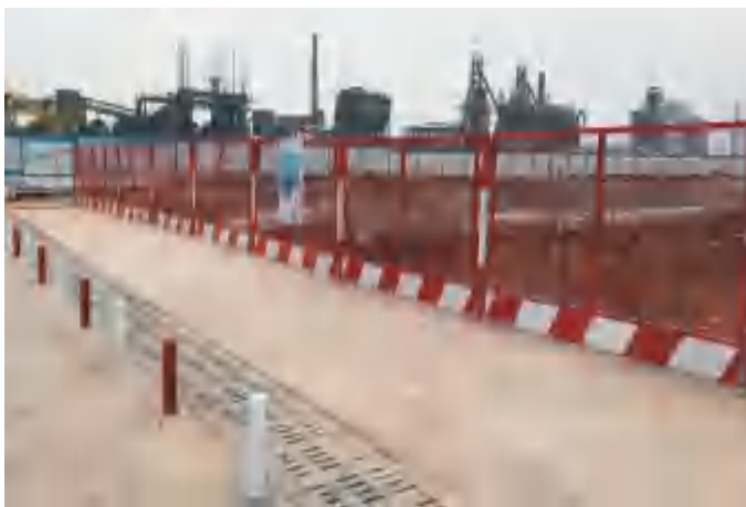
基坑周边设置排水沟及围挡
