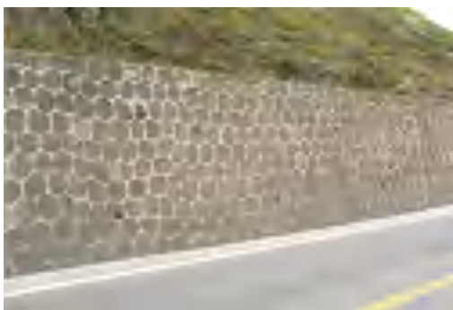
片石挡土墙护坡
