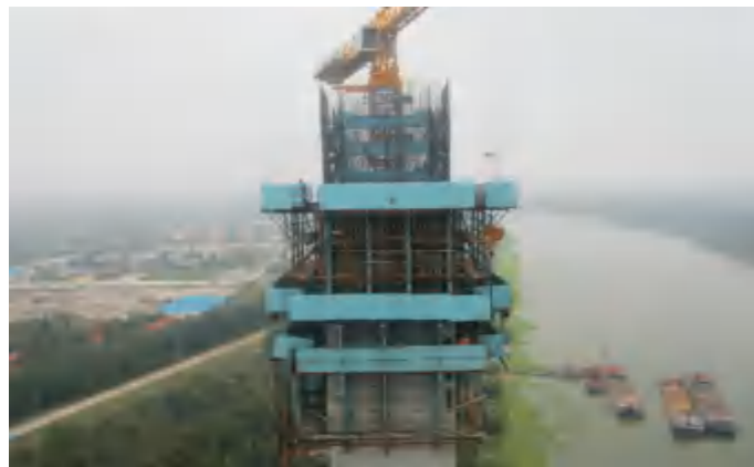
现浇混凝土索塔施工
