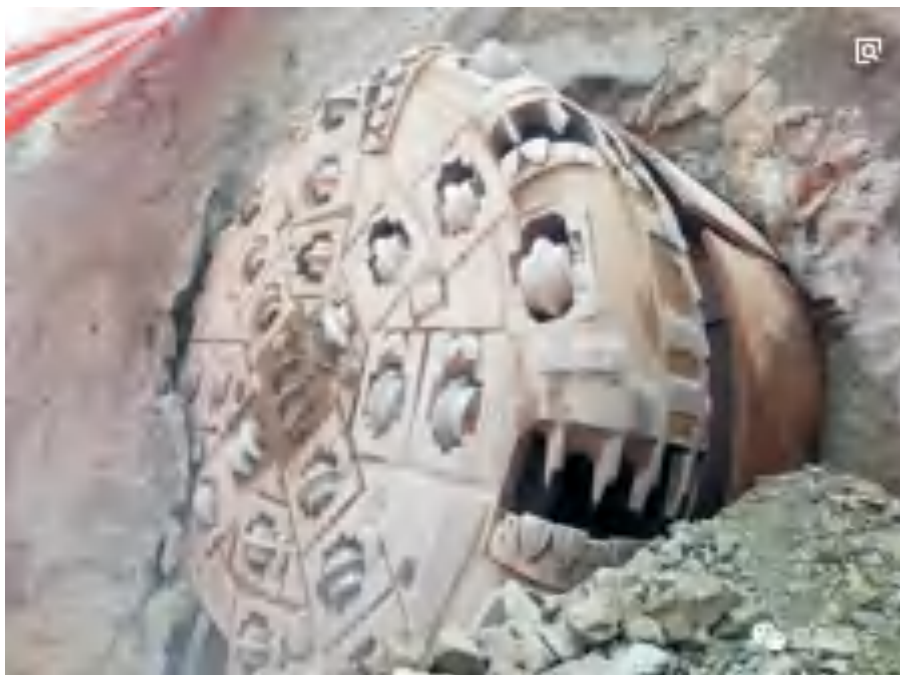
TBM到达掘进
