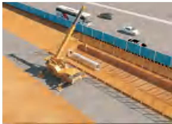
管道施工防护
