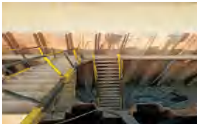
围堰上下通道
