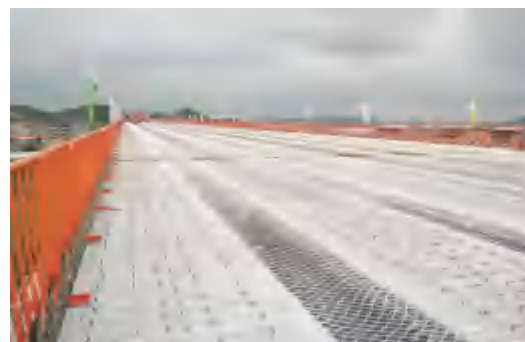
桥面临边及湿接缝防护
