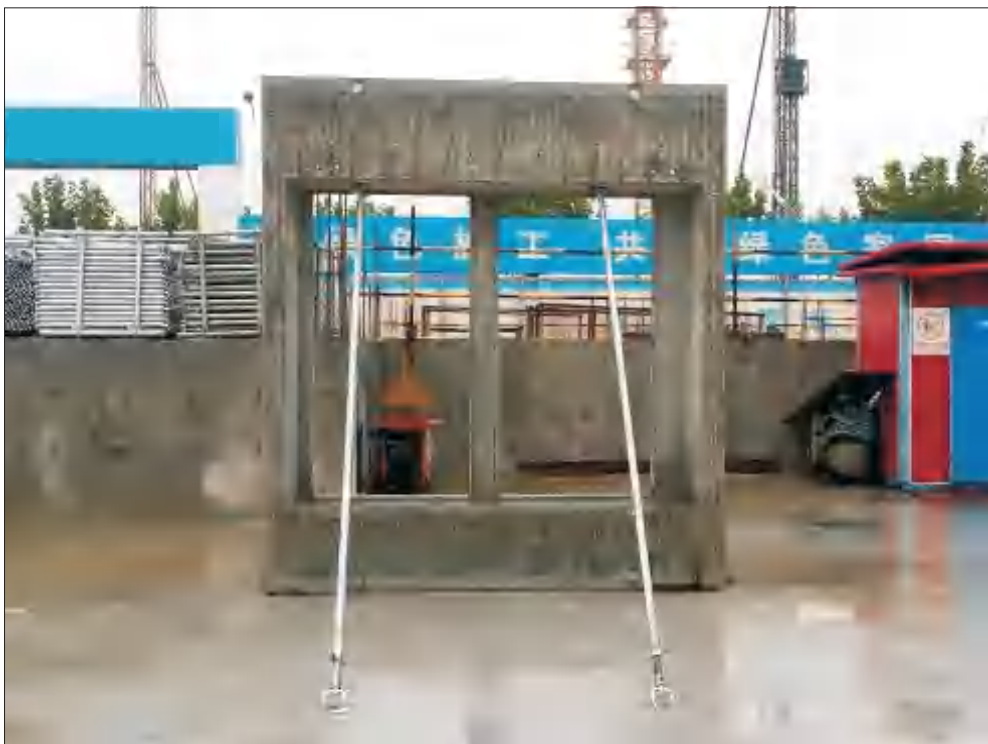
PC构件临时固定
