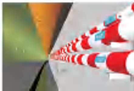
高压风管、水管及排水管
