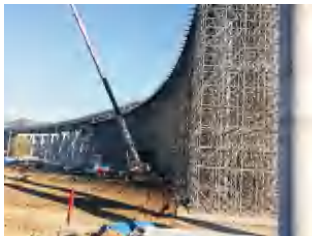
盘扣式支撑体系示意图
