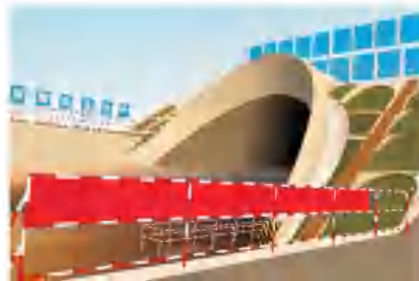
洞口仰坡防护
