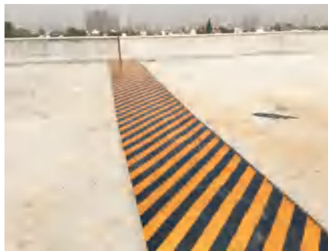
桥面伸缩缝防护
