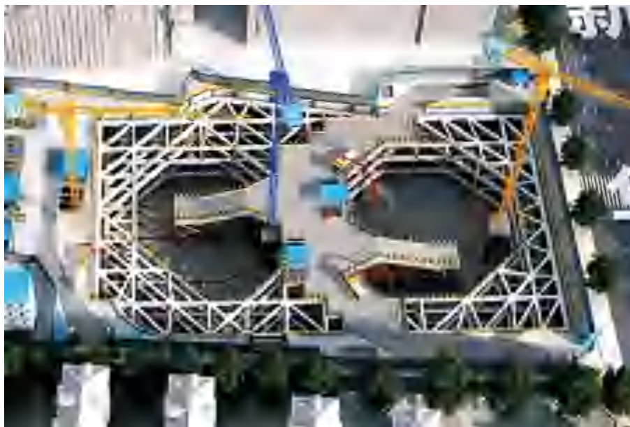
钢筋混凝土支撑示意图
