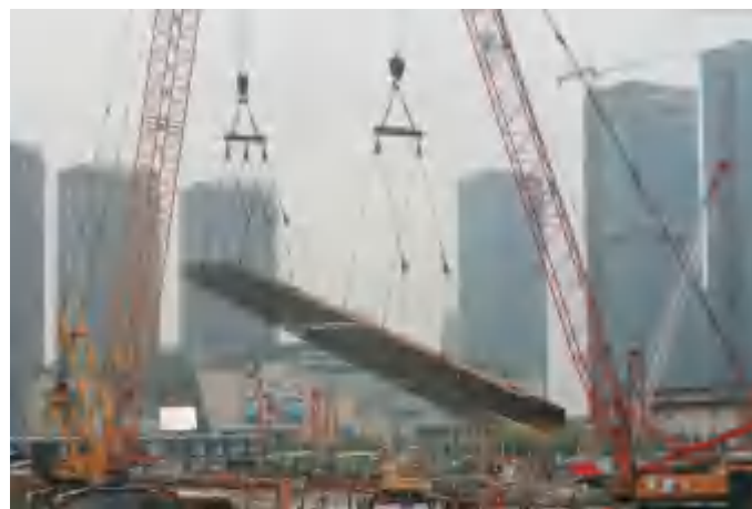
地连墙钢筋吊装
