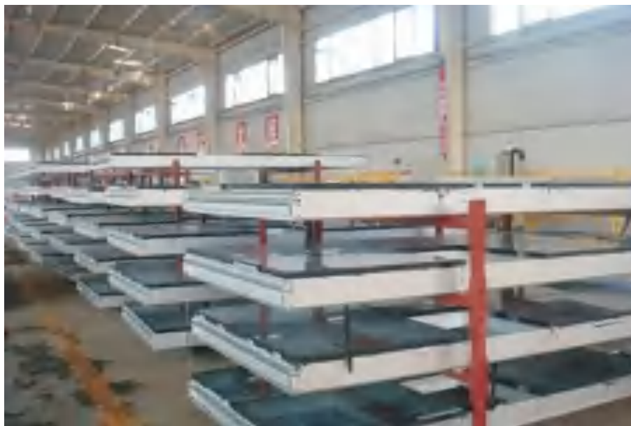
幕墙施工阶段材料堆放示意图
